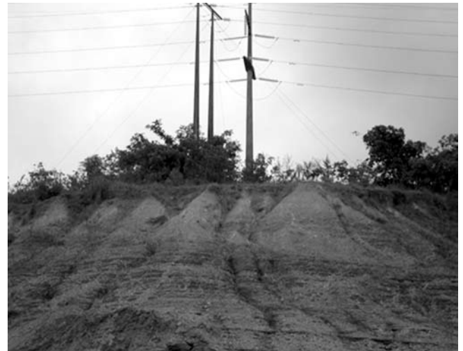
Figura 3. Indícios de processo erosivo nas encostas da jazida.
