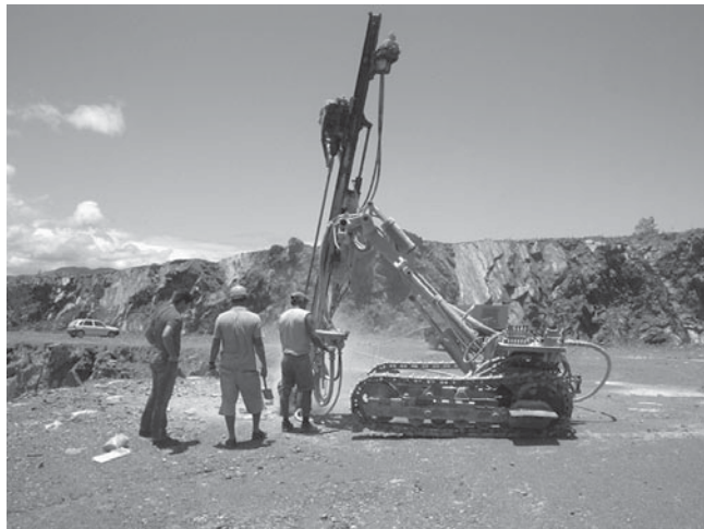
Figura 3. Perfuração com equipamento "rock drill" respeitando inclinação do corpo.
