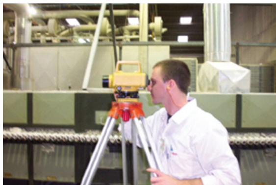
Figura 7. Operação de nivelamento.
