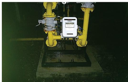
Figura 18. Medidor digital usado para conferir o consumo de gás.
