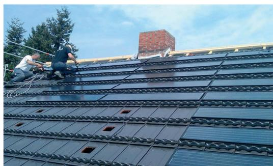
**Figura 4-5.** Sistema de energia MS5 2 Power para geração de energia e utilização de calor. Fonte: Dachziegelwerk Nelskamp GmbH, Werk Nibra, Alemanha.
