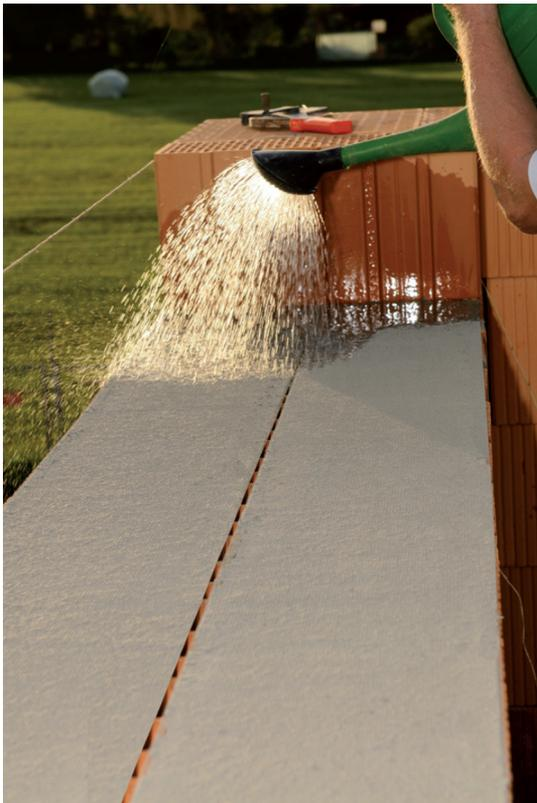
**Figura 2.** Molhamento de uma fita de argamassa desenrolada sobre uma parede de tijolos. Fonte: Ziegelwerk Martin Pichler GmbH, Aschach, Áustria.
